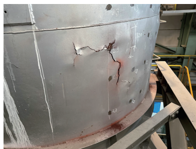
環境センターの状況
